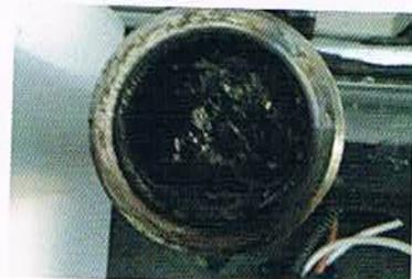
Magnetitschlamm verstopft die Siebe von Wärmetauschern.
