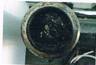
Magnetitschlamm verstopft die Siebe von Wärmetauschern.
